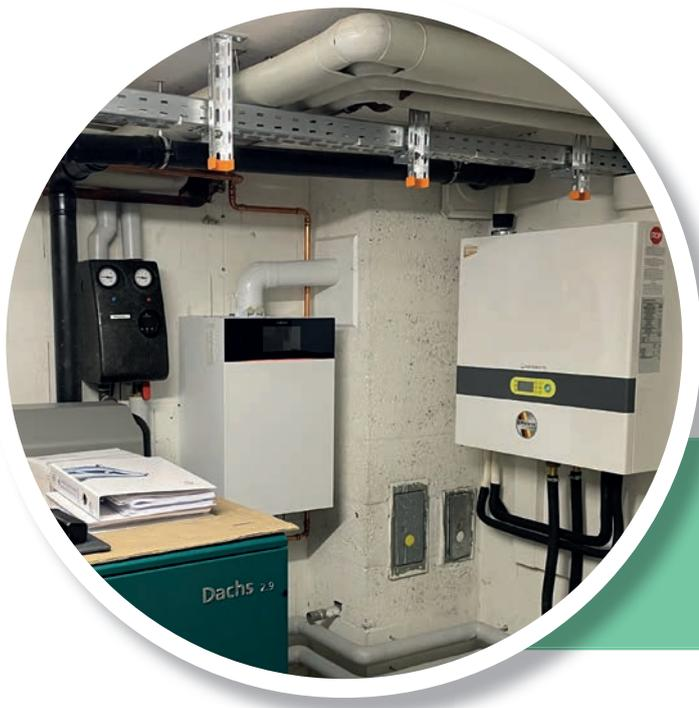
Hier sehen Sie das Hydraulikmodul der Wärmepumpe, die Kraft-Wärme-Kopplung, in diesem Fall der Dachs 2.9, und ein Nachheizsystem für die richtig kalten Tage.
